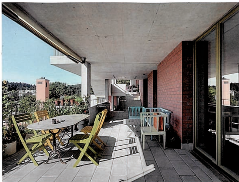
Ein Neubau mit großzügigen offenen Terrassen und Treppen verbindet zwei 1970er-Jahre-Bauten
