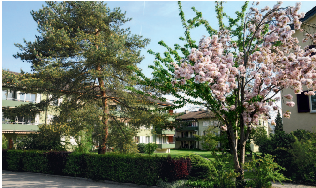
Die Häuser von 1948 und 1954 sollen abgebrochen werden.
