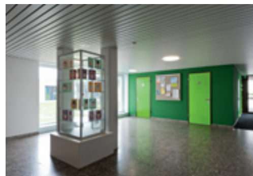
Foyer Klassentrakt mit Vitrine und neuer WC-Anlage
