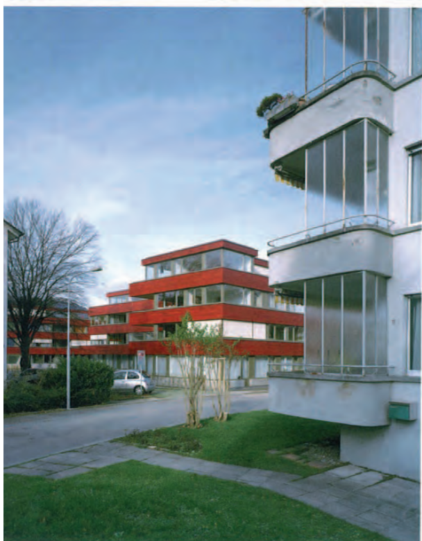
Der Lienihof in Zürich-Wollishofen: Durch die Vor- und Rücksprünge der äusseren Abwicklung entstehen spannende Aus-, Durch- und Einblicke.
