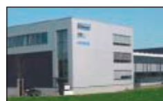
Büro- und Fabrikationsgebäude Ernst Schweizer AG Metallbau Hedingen
