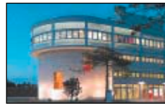
ara glatt, bilden und begegnen schockguyan architekten GmbH Zürich
