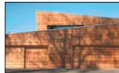
Wassersportzentrum Lido, Rapperswil SG Roskothen Architekten GmbH Rapperswil
