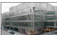
UBS AG Zürich, Sanierung Bäregasse 16 Andres Carosio Architekten Luzern
