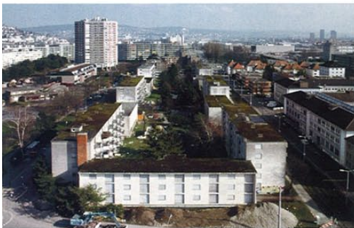
Das Werden eines Ersatzneubaus. Die rund 40-jährigen Bauten an der Bernerstrasse wurden abgebrochen, nun wächst die Neubausiedlung Werdwies heran.
