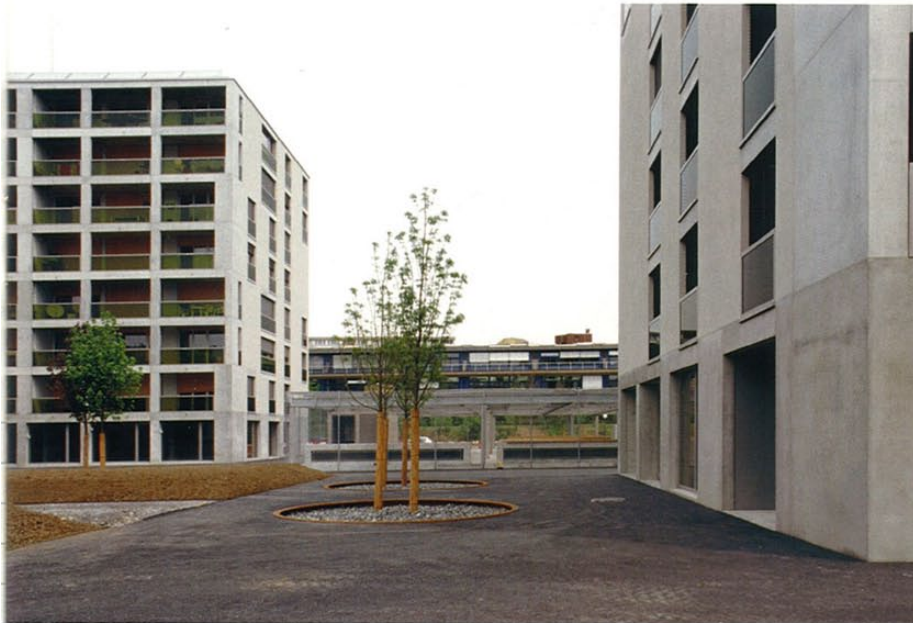
Zwei der sieben achtgeschossigen Bauten mit insgesamt 152 Wohnungen sind fertig.
