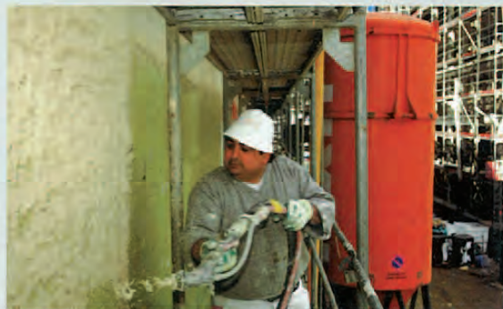
Die mineralische Spritztechnik ermöglichte der Arge Fassadenbau ein effizientes Arbeiten beim Grossprojekt.
