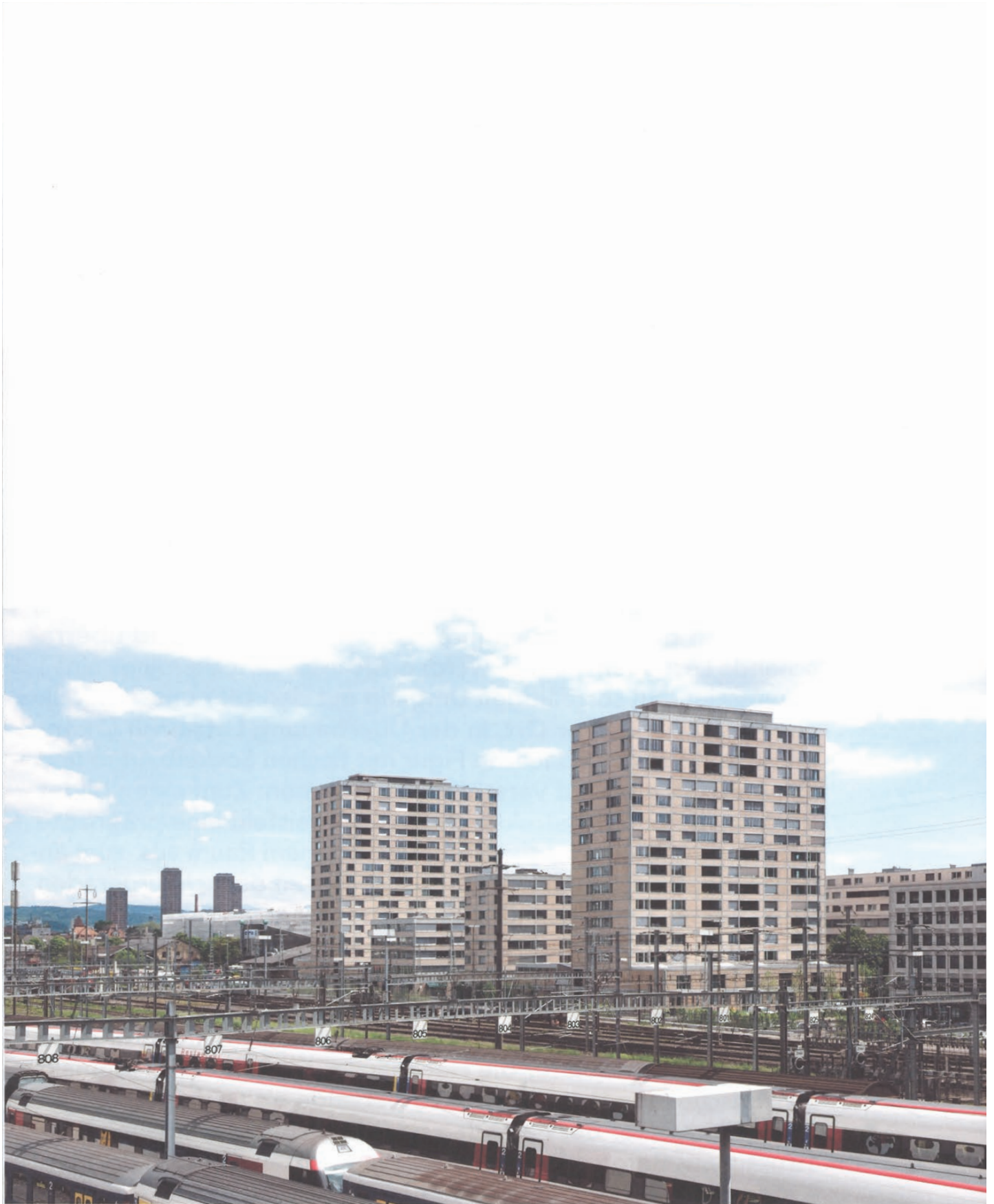
60 ↑ Neue Stadtkante: Die Hochhäuser nehmen den Massstab des weiten Gleisfelds auf. → Die schmalen, zweigeschossigen Eingangshallen stossen durch das ganze Gebäude.
