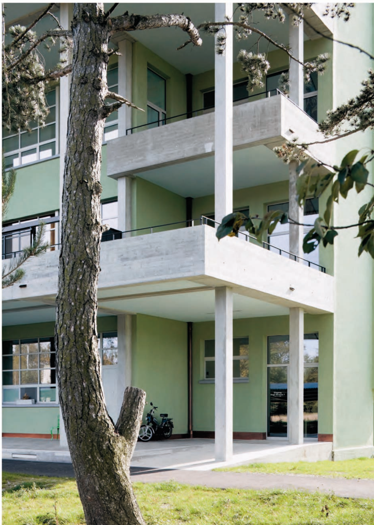
Ebenso pragmatisch und radikal wie die alte Fabrik: Das neue Betonregal vor der Nordfassade nimmt die Laubgänge auf und die privaten Aussenräume.
